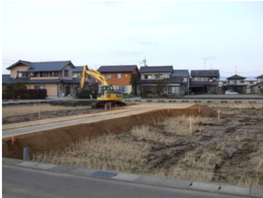
水田への客土の様子
